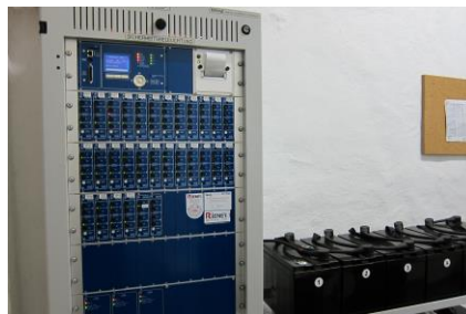
Notbeleuchtungsanlage
