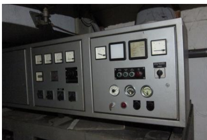
Ehemaliges Notstromaggregat des Luftschutzbunkers
