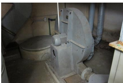
Alte Belüftungsanlage des Bunkers
